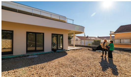
Izgradnja dječjeg vrtića u Gornjem kraju
